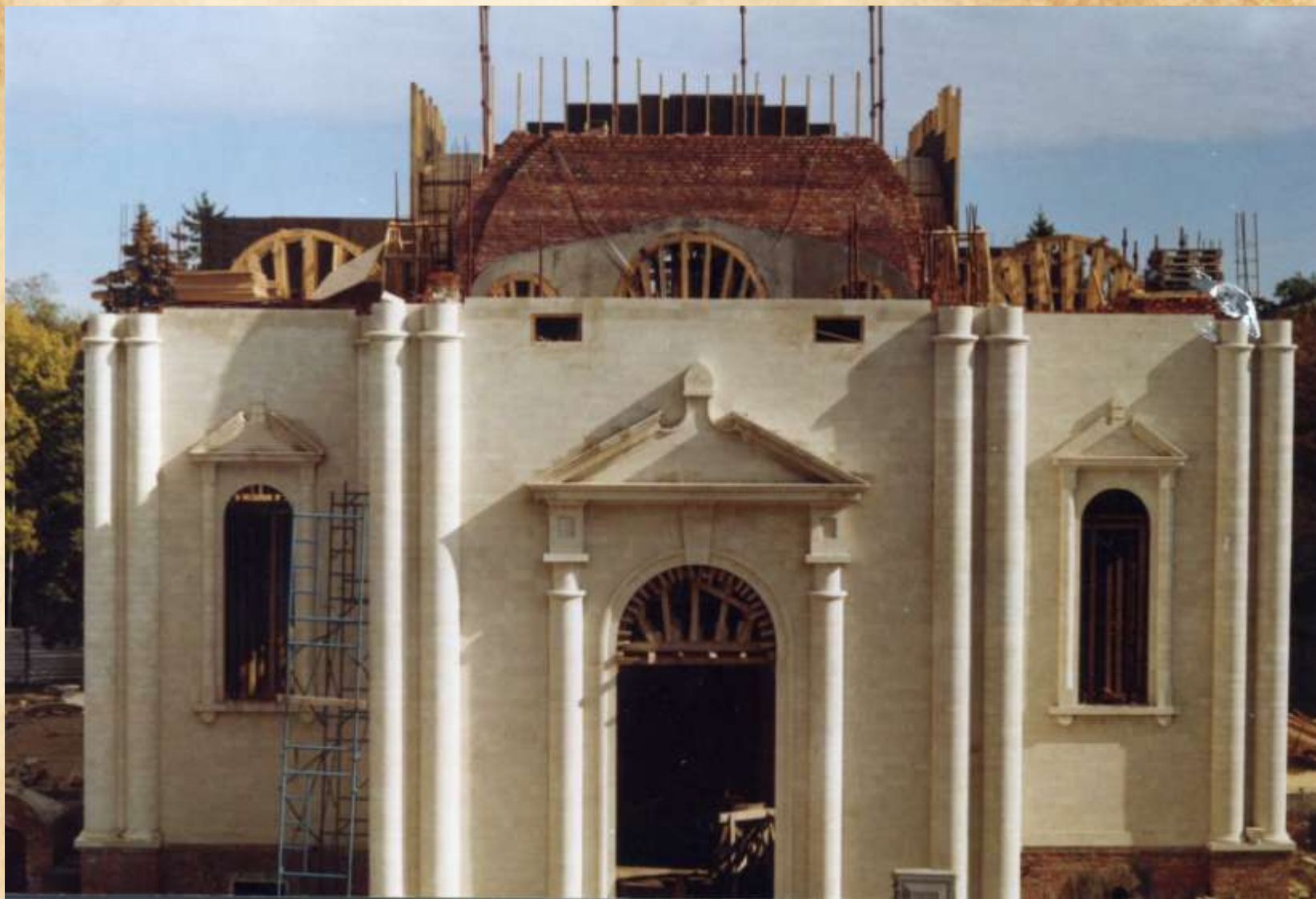
Строительство Кафедрального собора на Комсомольской горке в городе Ставрополе. Опалубочные работы. 2006 год.
