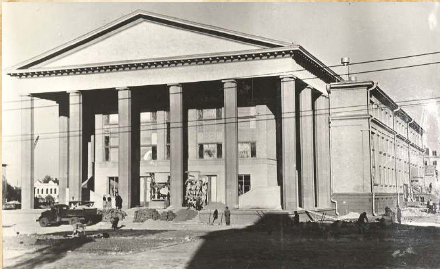
Строительство нового здания Ставропольского краевого драматического театра. 1964 год.
